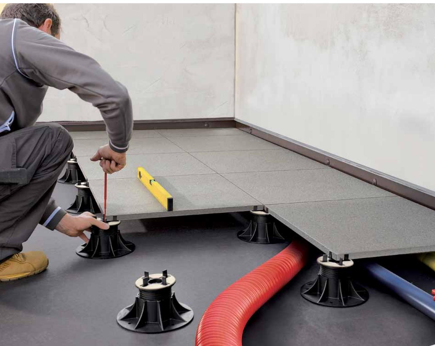
Per la pavimentazione sopraelevata, le lastre CM2 sono fornite di supporti portanti in polipropilene 100% riciclato, resistenti agli acidi e agli agenti atmosferici.
